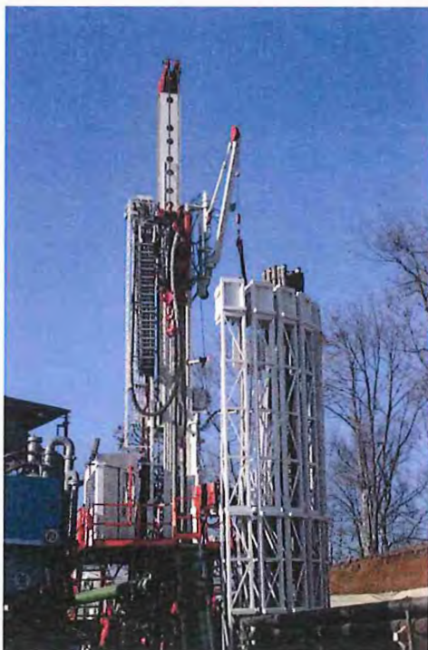
Instalație de foraj HH 75 – Drillmec Italia
